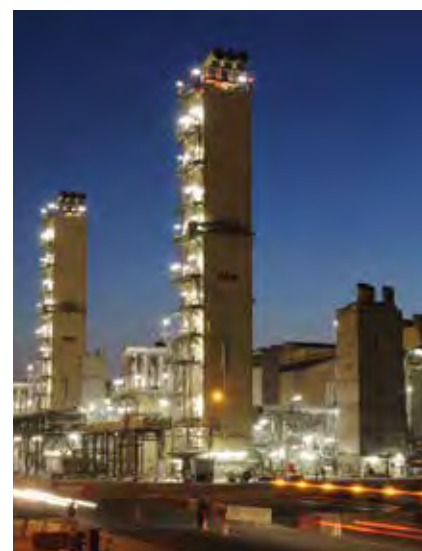
PEARL GTL, KATAR Endproduktfraktionen zerlegt wird.
